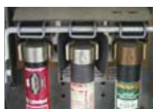
Instalación eléctrica: fusibles recalentados
