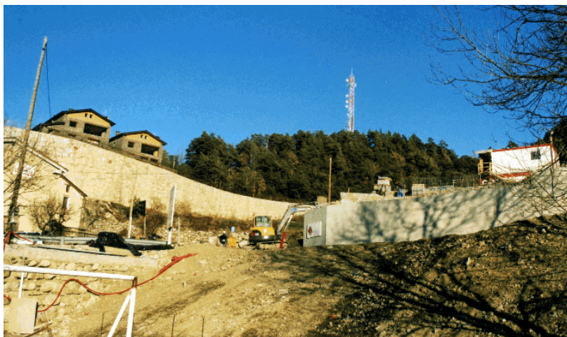
Torre de telecomunicacions a la Comella
